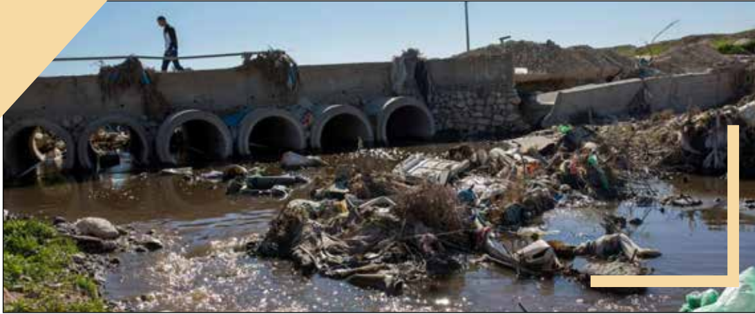
صورة 39: شبكات البنية التحتية للصرف الصحي في القرى البدوية المعترف بها: غالبية القرى المعترف بها لا يوجد فيها شبكة صرف صحي، ويتم صرف المجاري بطرق قد تضر بجودة البيئة وحياة المواطنين. هذه الصورة لوادي الخليل الذي يمر من وسط قرية أم بطين البدوية المعترف بها. (روتتم، ميخال، 2017)
